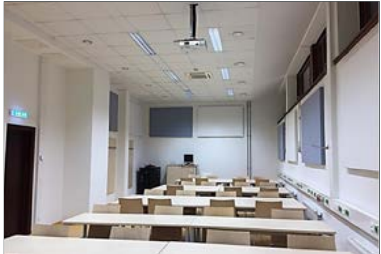
Abb. 14: Der Raum nach Abbildung 12 mit 10 zusätzlichen, 5 cm dicken Akustikpaneelen an drei Wänden
