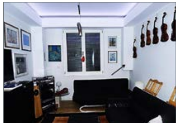
Abb. 19: Kanten-Absorber in „verdeckter“ Bauweise an Decke und einer Wand beidseitig der Stereo-Anlage sowie zwei \lambda/4 -Resonatoren an der gegenüberliegenden Wand im „Hörraum“ der Casa Acustica
