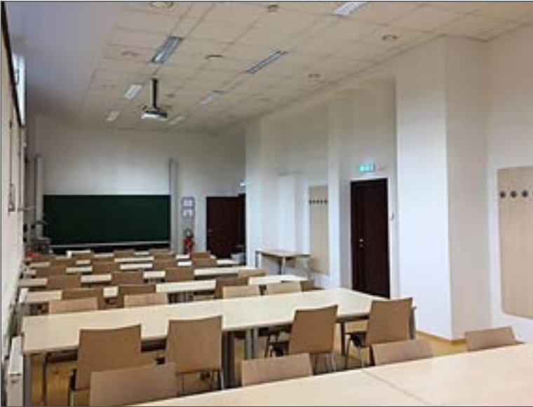
Abb. 12: Blick zur Flurwand eines der bemängelten Hörsäle (i14) an der TU Graz im Ausgangszustand mit einer großflächig abgehängten Akustikdecke
