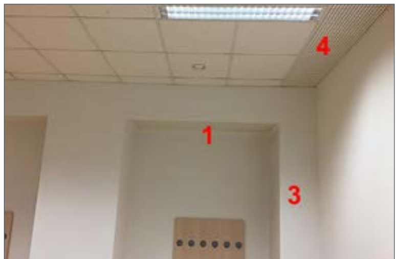
Abb. 16: Die mit einer zusätzlichen Mineralwolle-Auflage belegten GK-Lochplatten (4) ersetzen die bereits vorhandenen UD-Platten in einem 42 cm breiten und 3,6 m langen Randstreifen
