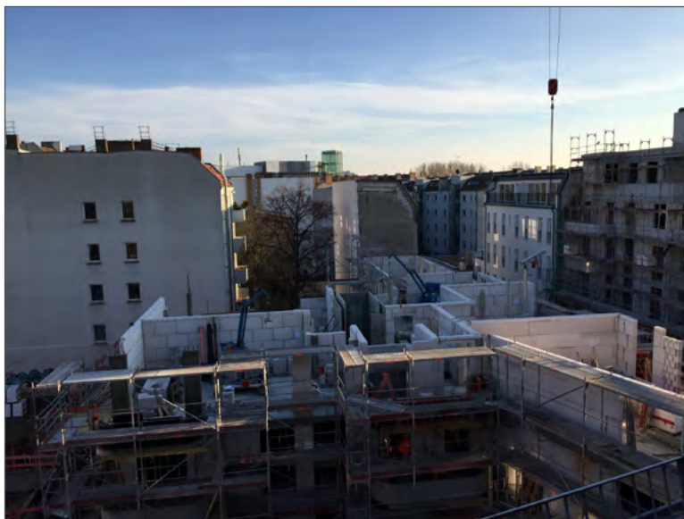
Abb. 5: Innerstädtische Verdichtung, Foto: E. Baumer
